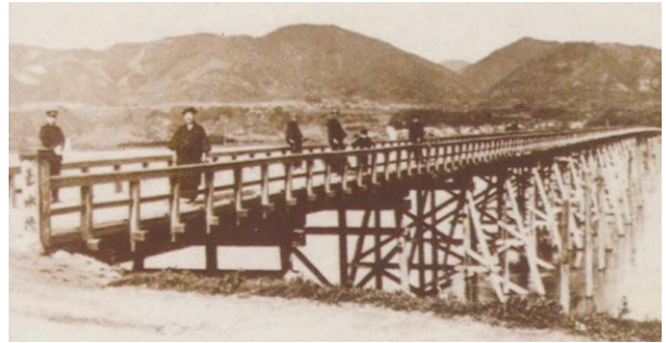
明治 37 年に架橋された初代玉水橋
