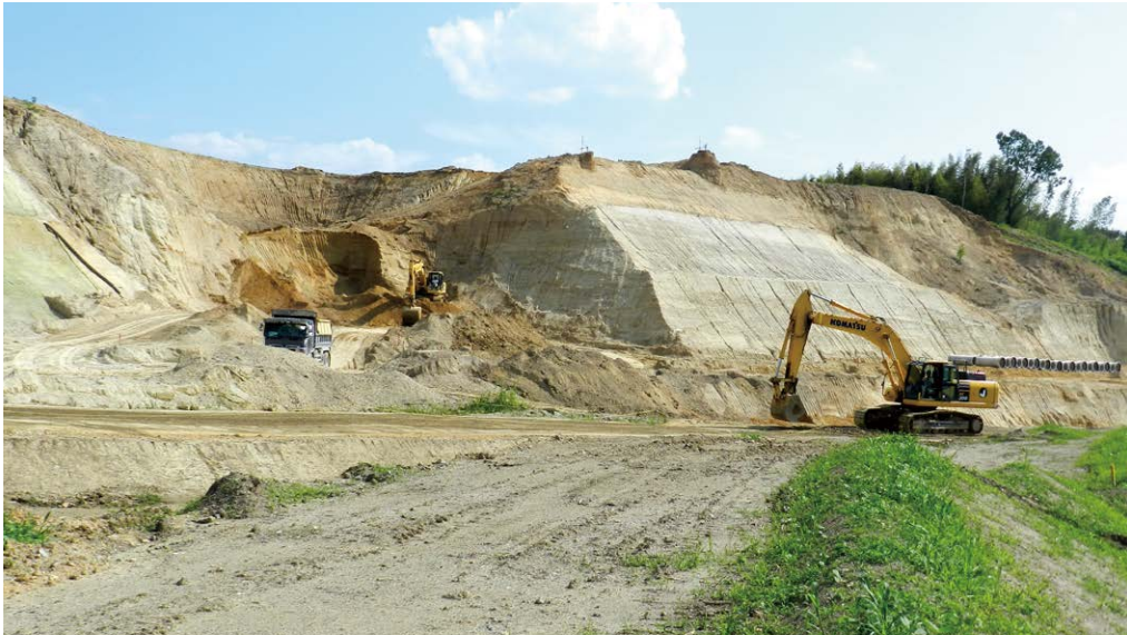
工事が進む白坂区域
