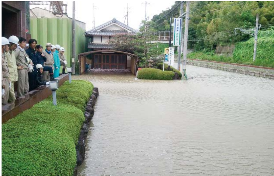
豪雨による浸水場所
