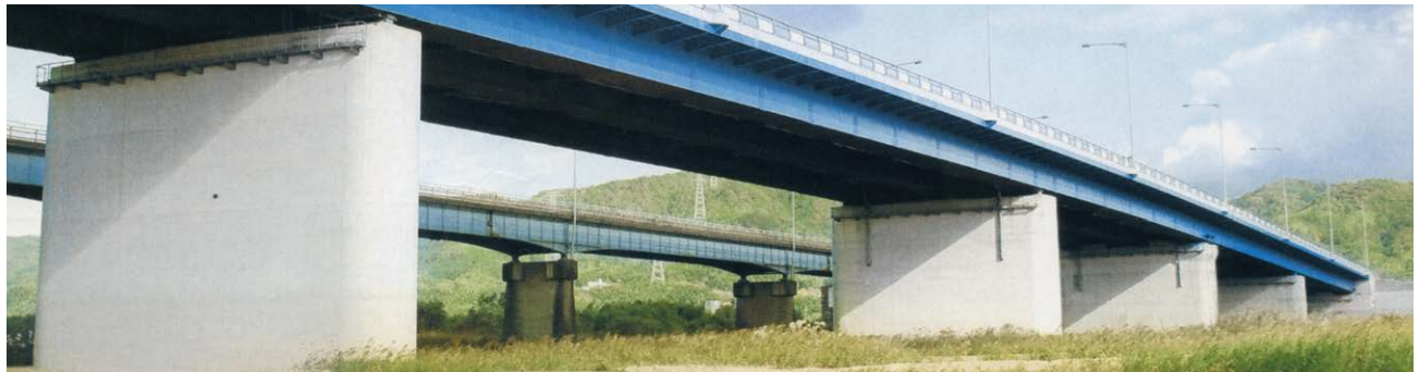
手前は平成 15 年に完成した玉水橋、向う側は昭和 37 年架橋の旧玉水橋
