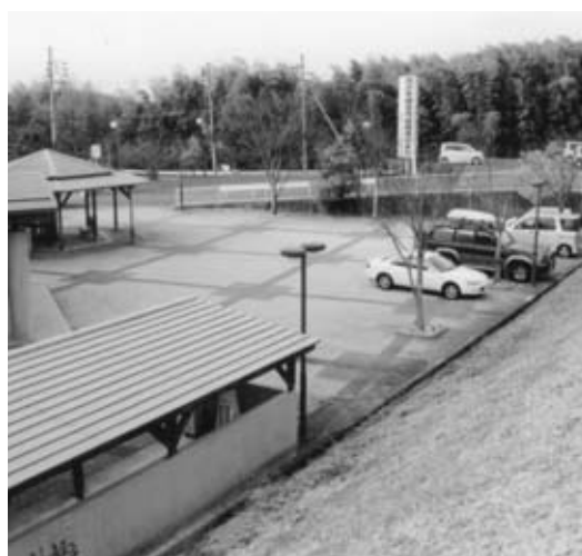
拡張が望まれる自休村センター駐車場
