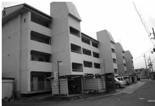
耐震化が待たれる改良住宅
