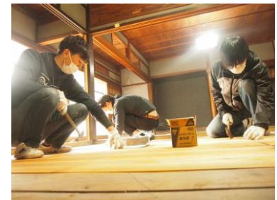
古い畳、伐採樹木の処分、床の張り替え、清掃等は学生自らの手で実施
