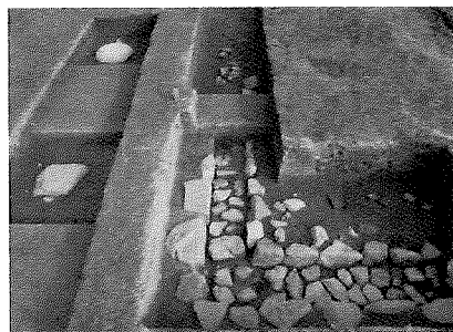
(僧坊推定建物の礎石と雨落ち溝)
