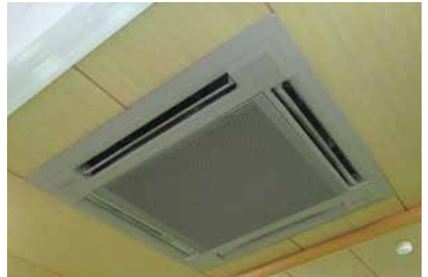
老人福祉センター空調改修
