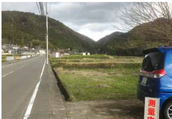
測量が進められるバイパス道路予定地
