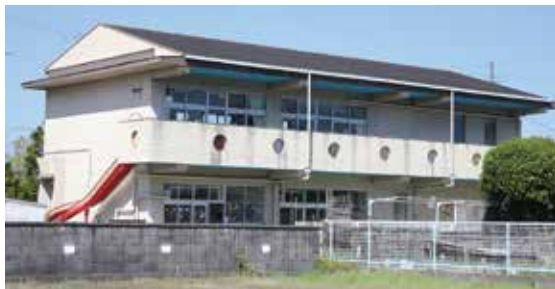
改修予定のいづみ保育園(内装)
