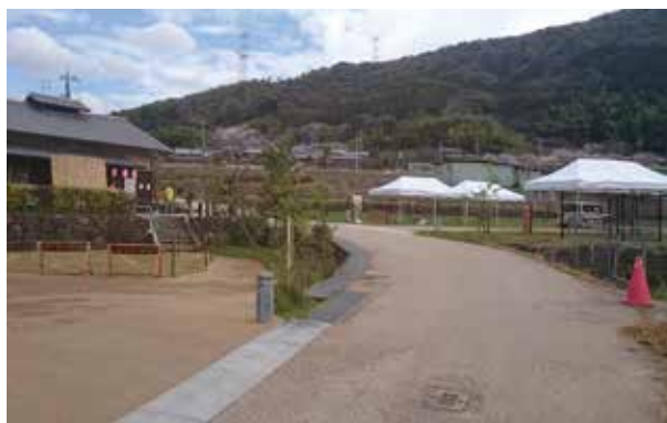
交付金を活用して整備される椿坂周辺
