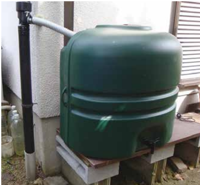
他市町で設置されている雨水タンク
