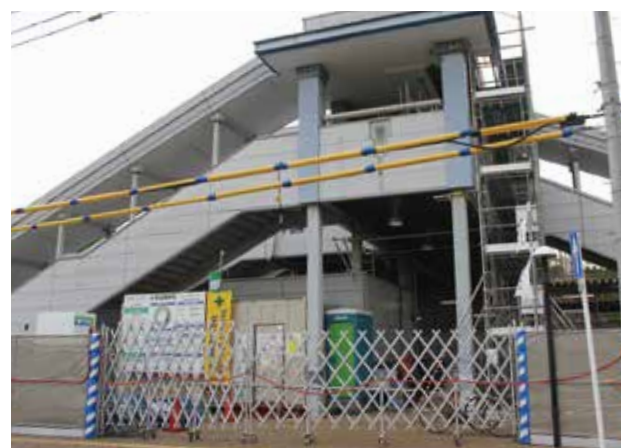
山城多賀駅のエレベータ設置工事
