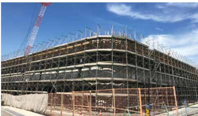
建設中の特別支援学校
