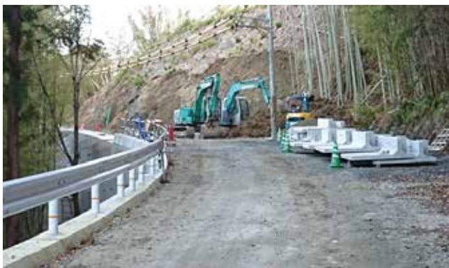
町道3号線改良工事
