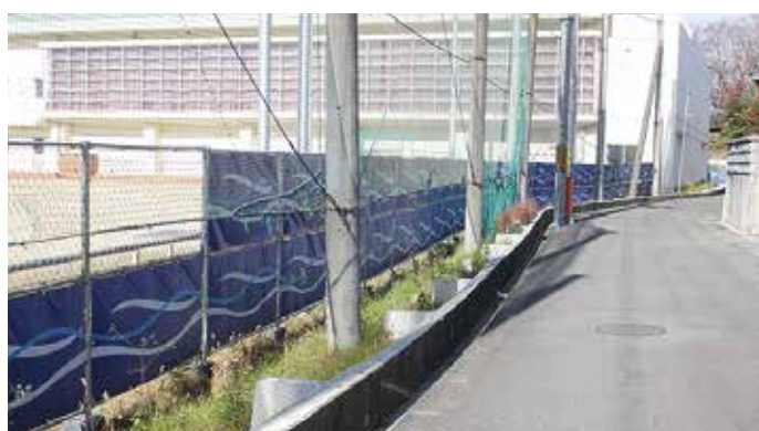
改修中のフェンス工事（泉ヶ丘中）
