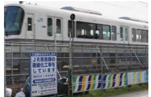
進む複線化工事
