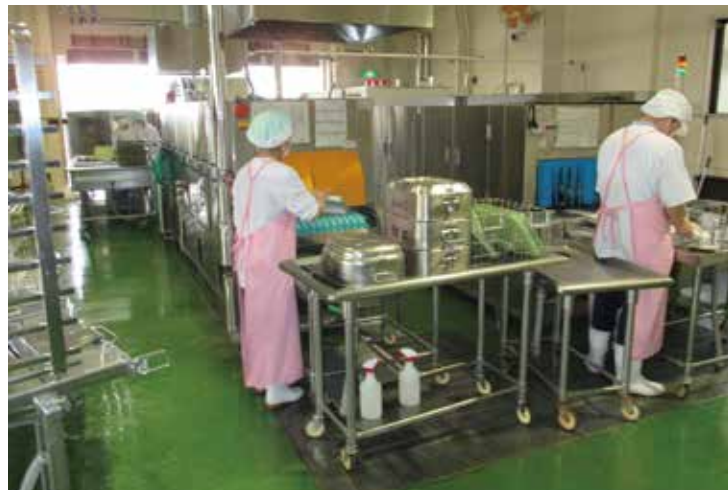
改修を検討中の給食センター調理室
