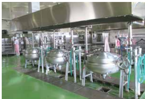
改修予定の給食センター調理室
