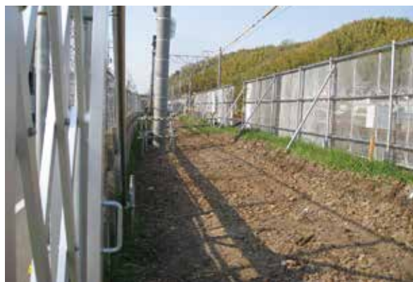
複線化工事が進むJR奈良線
