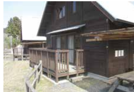
改修予定のウッドデッキ
