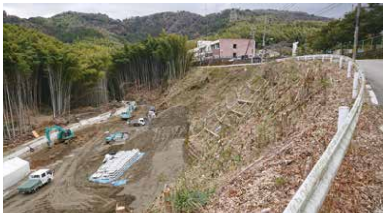
拡幅工事中の町道3号線
