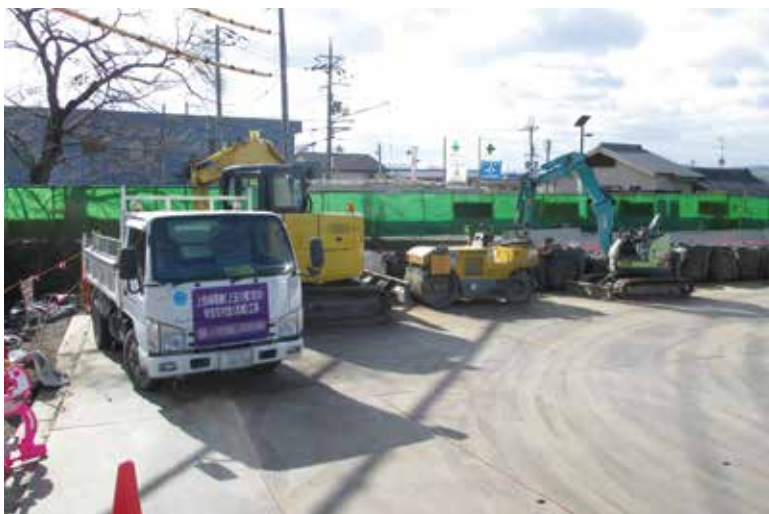
予定通り進行中の上玉川橋架替工事
