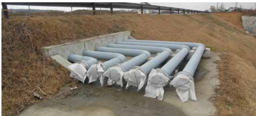
国道24号を横断する排水パイプ
