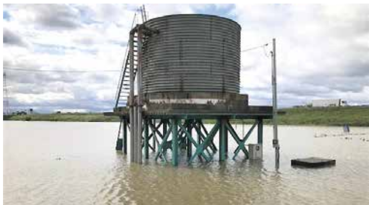
台風21号により冠水した揚水機場
