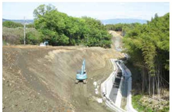
町道3号線 道路改良
