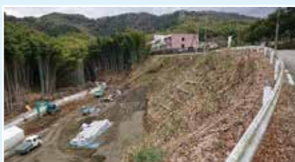
町道3号線改良工事
