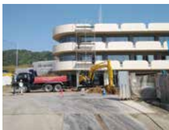
建設中の府立支援学校
