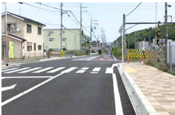
拡幅工事が始まる府道上粕城陽線
