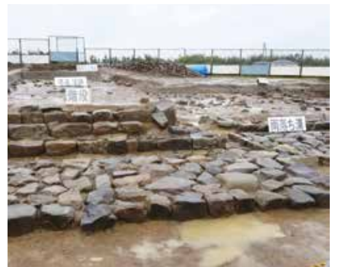
出土した五重塔基壇跡
