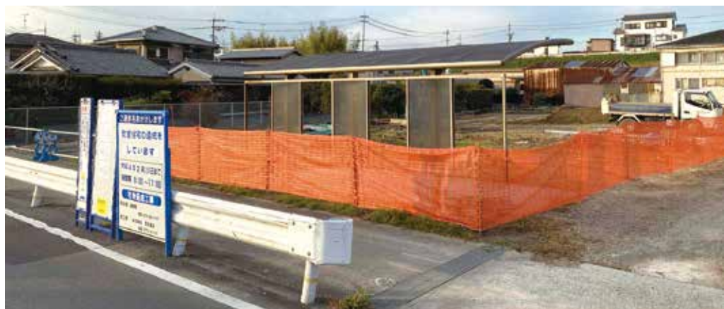
工事が進められる多賀地区町営住宅 (P2)
