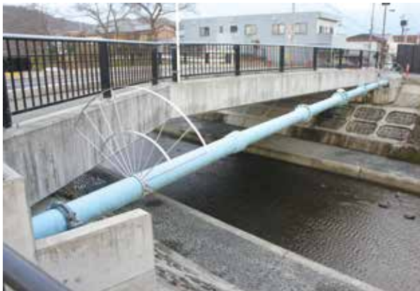
玉川にかかる水管橋
