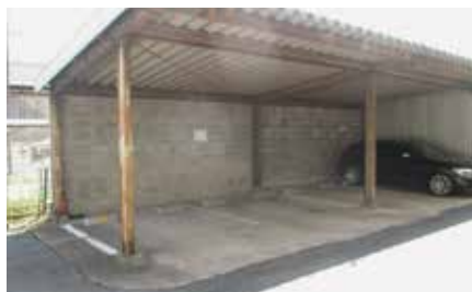
ブロック塀改修（役場）
