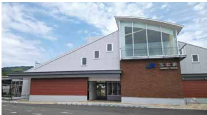
整備されたJR玉水駅・東西自由通路
