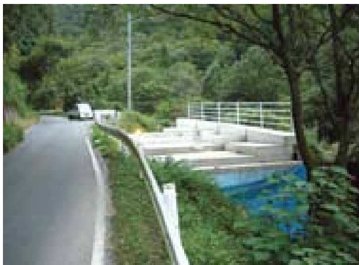
拡幅工事が進む和束井手線
