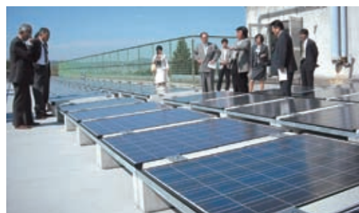
井手小の太陽光発電パネル
