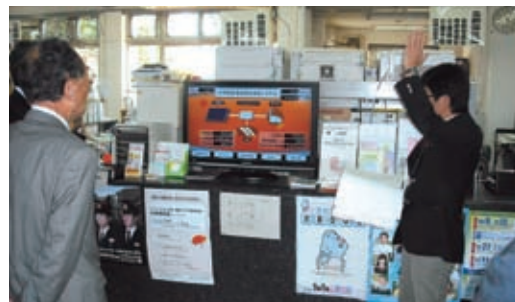
庁舎太陽光発電モニター
