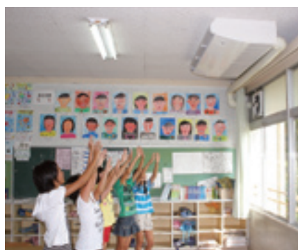
教室に空調設備設置
