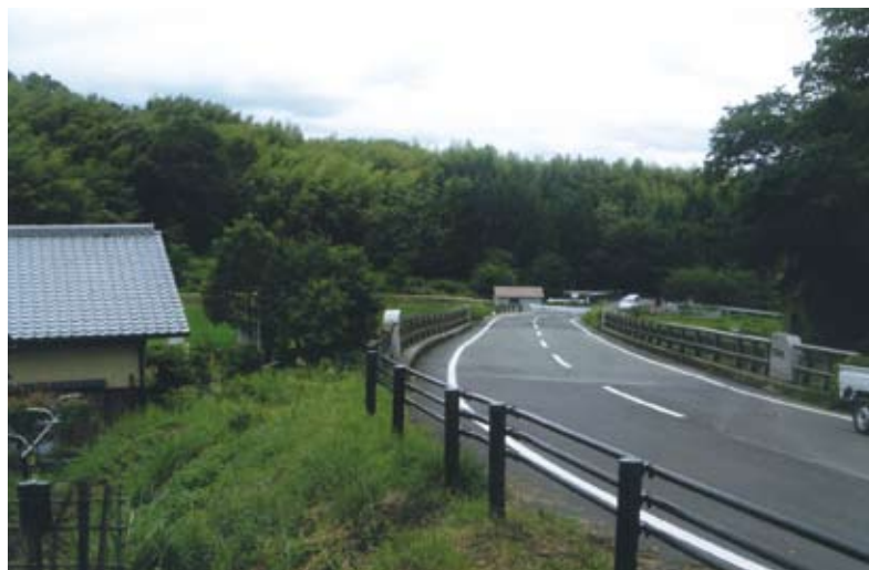
府道から橋本橋まで整備済の町道22号線
