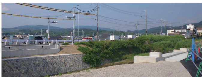
工事中の梅溪橋
