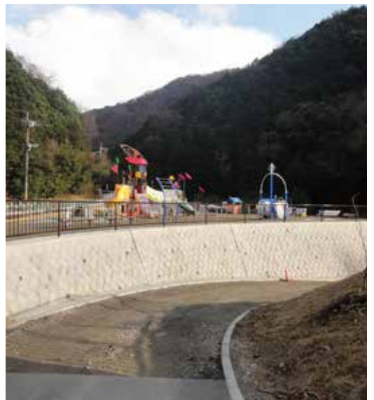
整備された玉川砂防公園
