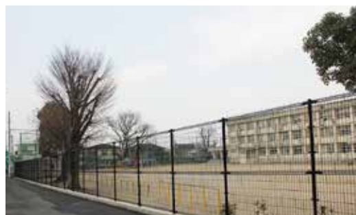
井手小 フェンス改修
