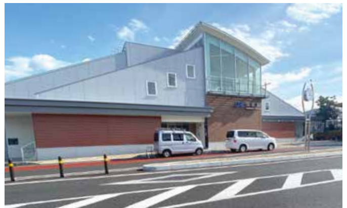
完成したJR玉水駅西側
