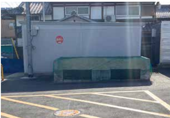
多賀地区防災広場に埋設された防火水槽
