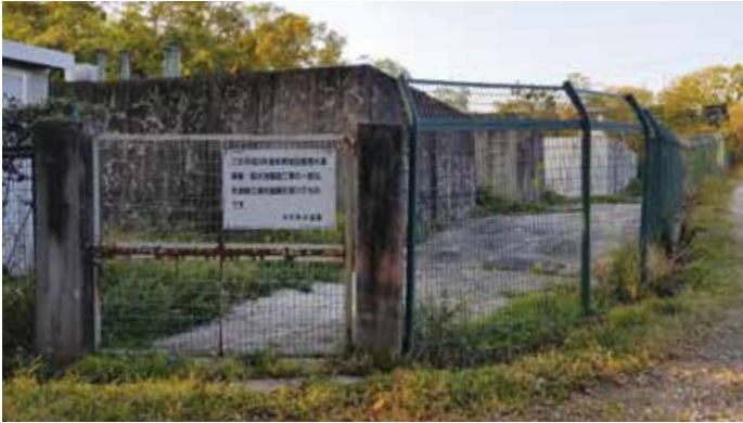
多賀地区配水池
