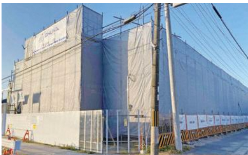
工事が進む多賀地区町営住宅
