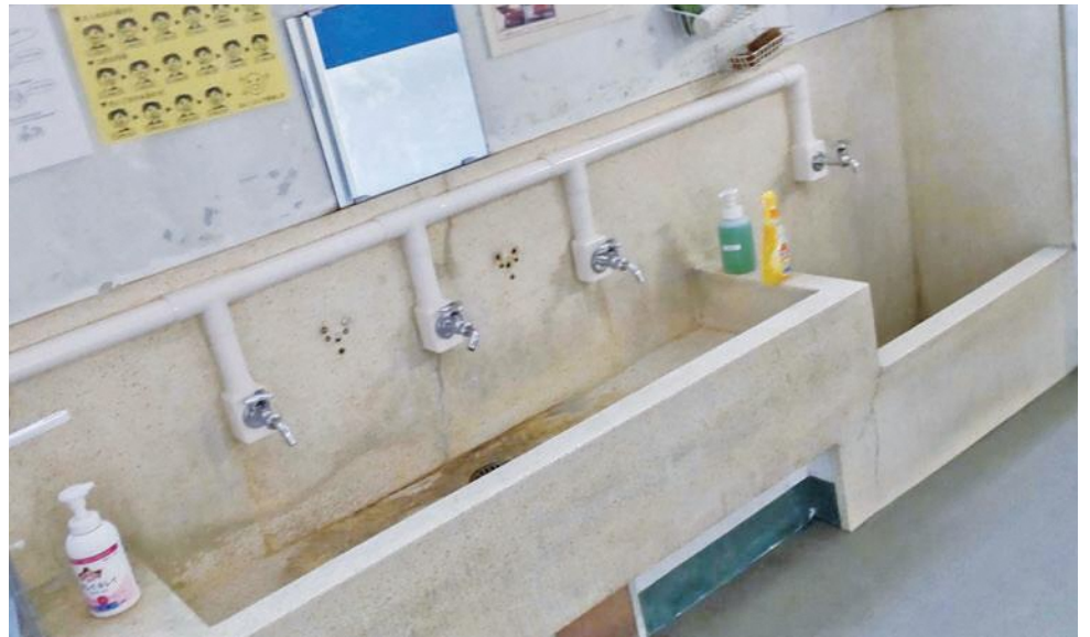
自動水栓への交換が望ましい小学校の洗い場
