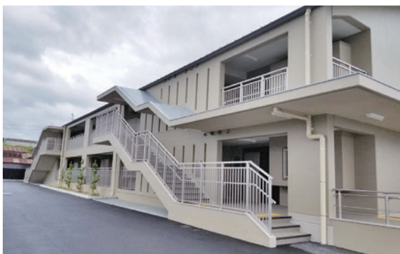
新しく建設された多賀地区町営住宅
