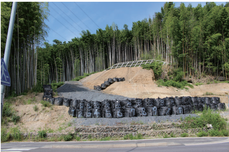
町道29号線道路改良工事の様子
