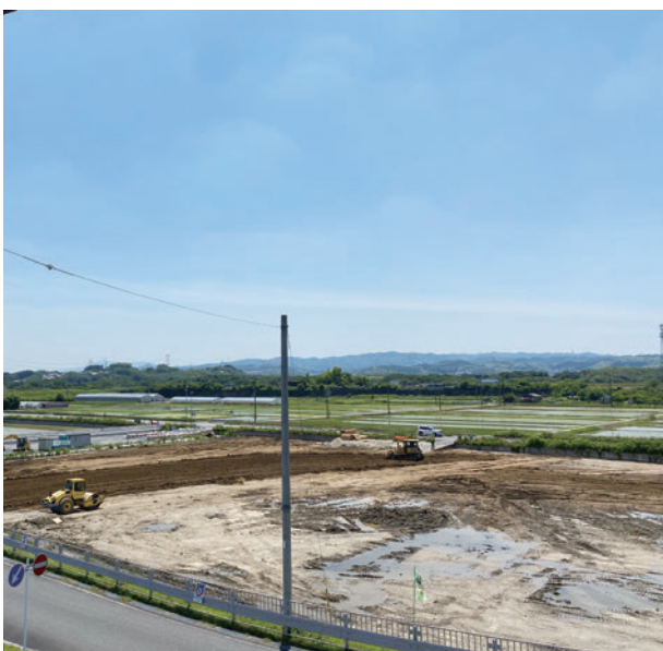
工事が進む山城多賀駅前
