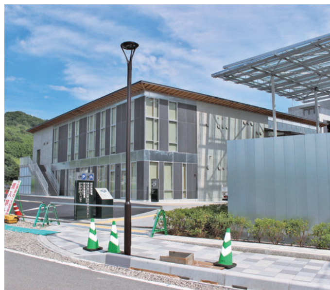
無電柱化に伴い設置された街灯
