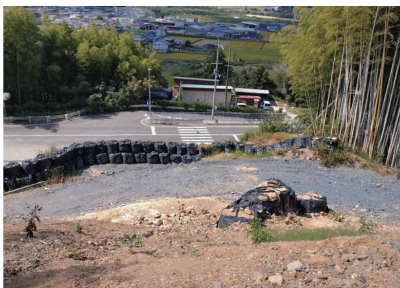
支援学校に続く町道29号線道路改良工事
