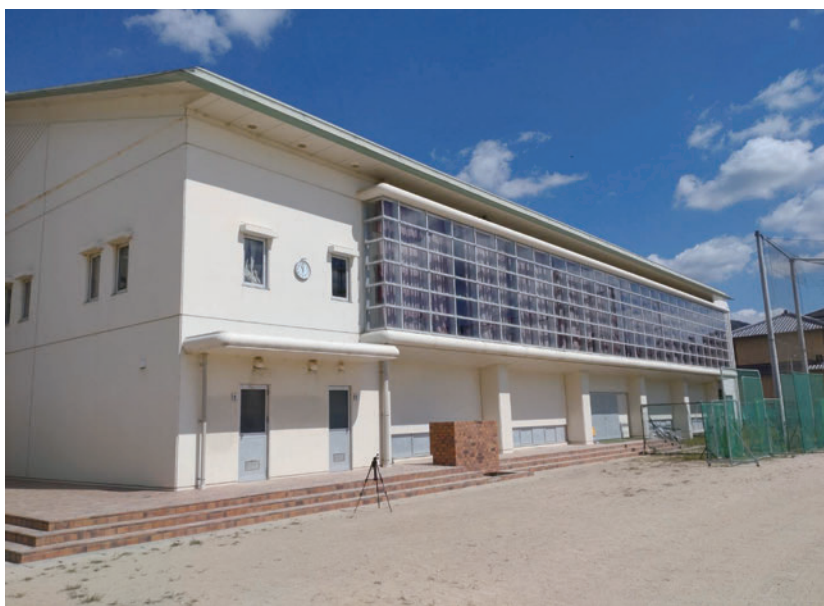
泉ヶ丘中学校 体育館
