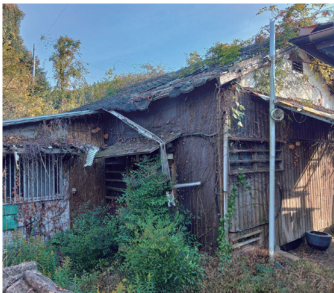
解体が予定されている旧多賀地区町営住宅
