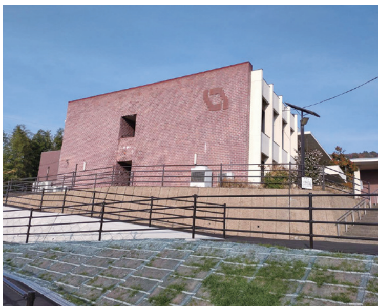
これからも利用される自然休養村管理センター
