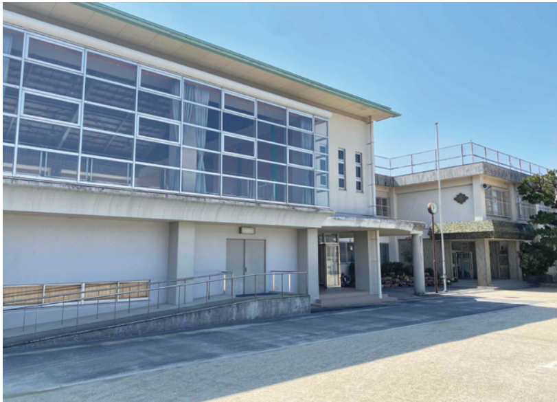
空調整備が予定されている多賀小学校
