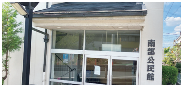
改修される南部公民館
