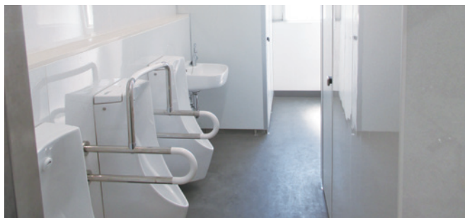
改修された泉ヶ丘中学校のトイレ
