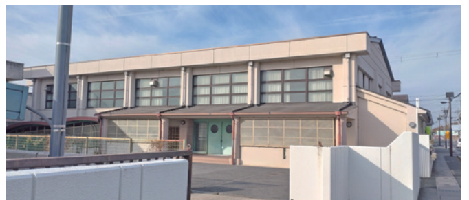
空調が整備される小学校の体育館（井手小学校）
