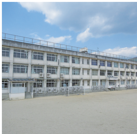
外壁が改修される井手小学校（南校舎）
