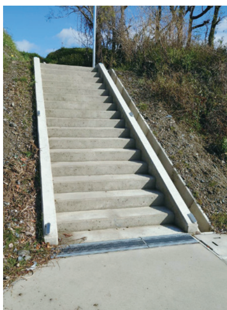
手すりの設置が待たれる連絡通路
