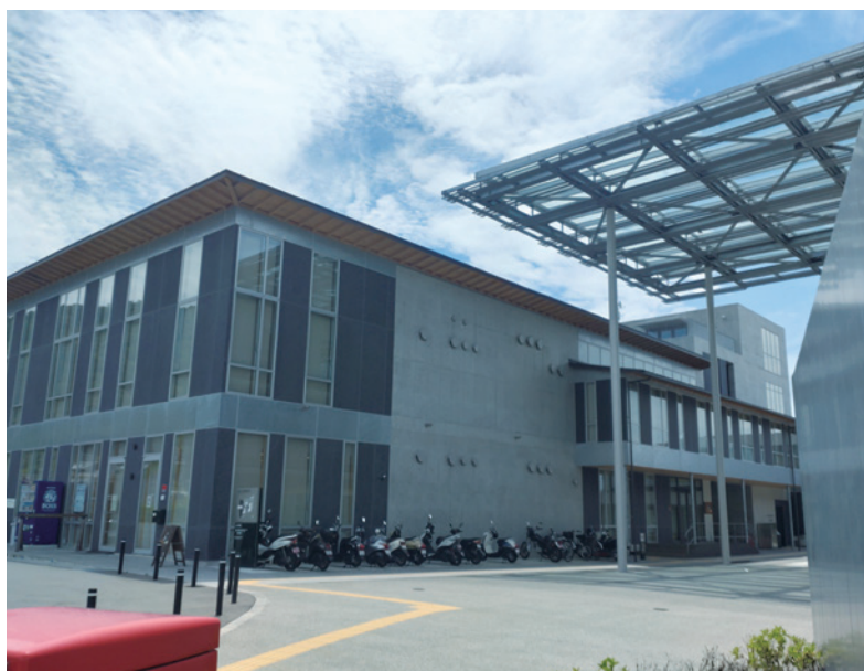
屋根の設置が待たれる役場の駐輪場
