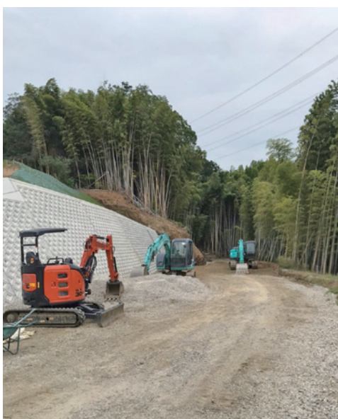
町道29号線第2工区道路改良工事の様子
