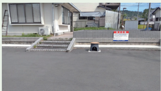
防災広場として整備された南溝児童遊園・緑地
