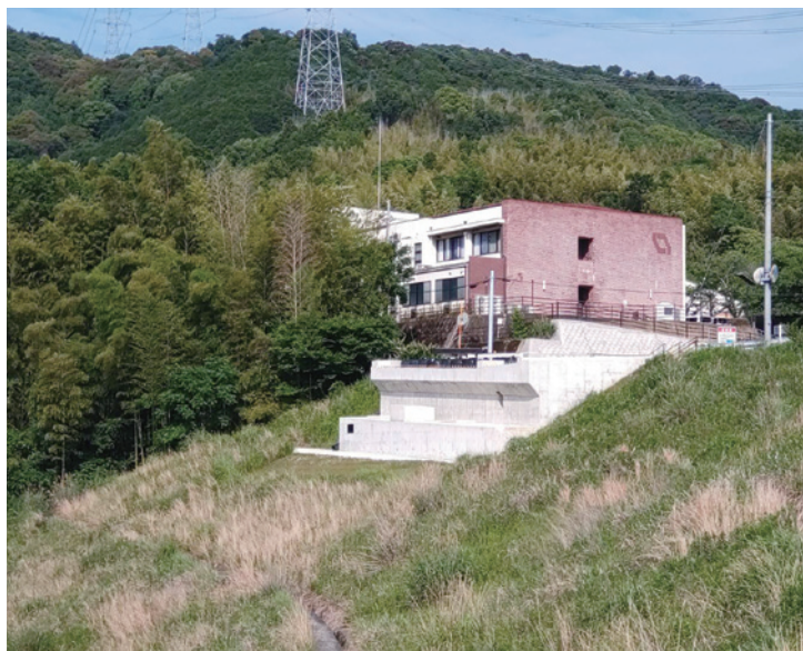
国道24号「城陽井手木津川バイパス」才田川橋の橋梁下部
