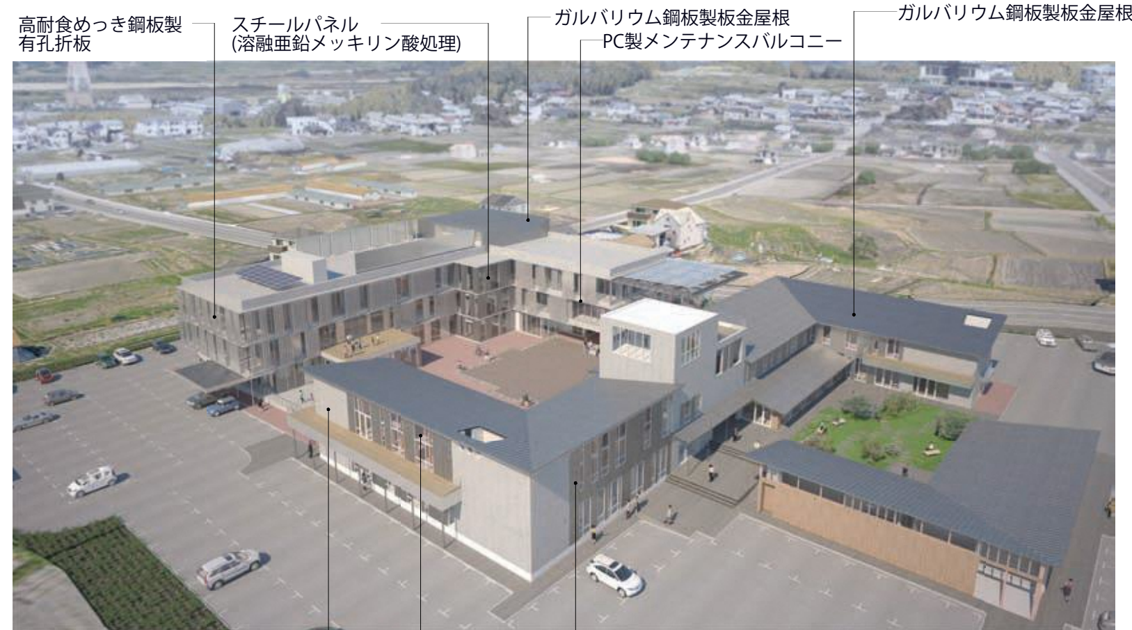
高耐食めっき鋼板製有孔折板 ガルバリウム鋼板製板金屋根 PC製メンテナンスバルコニー ガルバリウム鋼板製板金屋根 コンクリート化粧型枠打放し アルミサッシ スチールパネル (溶融亜鉛メッキリン酸処理) 鳥瞰イメージ 南東側より見る
