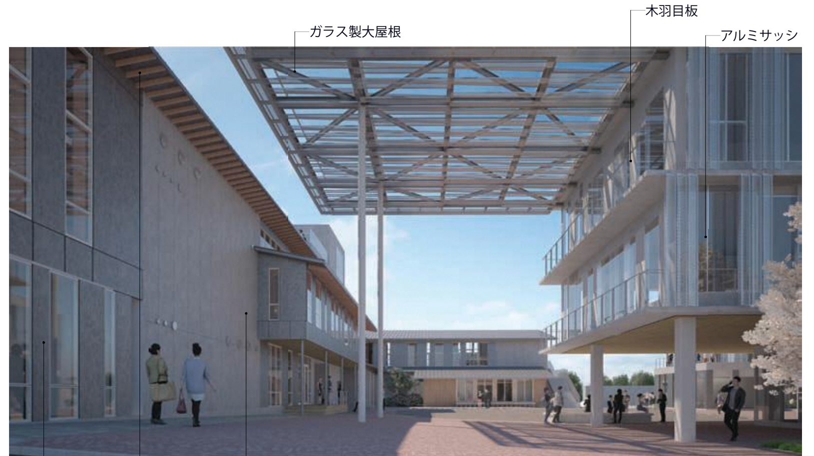
木羽目板 アルミサッシ 大屋根下より土間を見る コンクリート化粧型枠打放し 木梁現し スチールパネル (溶融亜鉛メッキリン酸処理)
