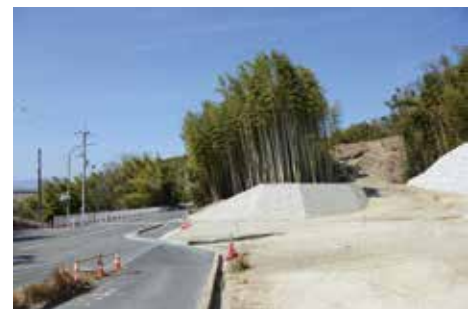
町道29号線道路改良事業
