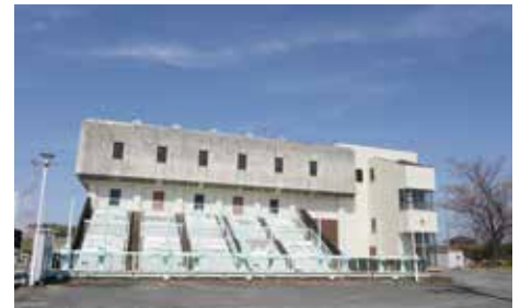
合藪ポンプ場
