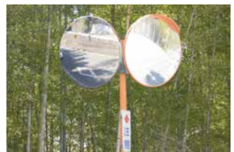
結露による曇り止め対策を施したカーブミラーを整備
